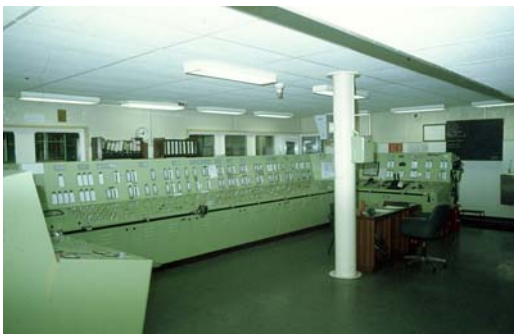
Het machine controle paneel in de zeer ruime controlekamer voorzien van vensters met uitzicht in de machinekamer. Niet inzicht tegenover het controle paneel de kasten met de elektronische automatisering.
