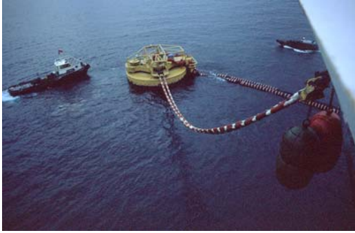
( De boei met rechts de slangen waardoor de lading wordt gepompt naar een installatie aan de wal.)
